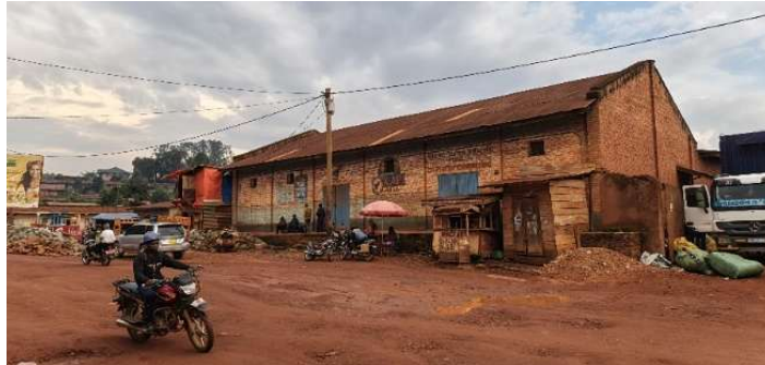
Figure 18 : Bâtiment de la CUGEKI.
