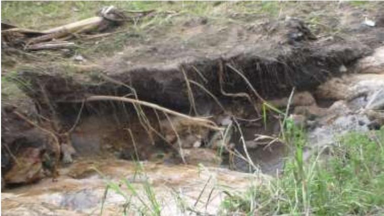
Figure 5 : Sol et altérite minces formés sur des roches dures du soubassement à faible profondeur.
