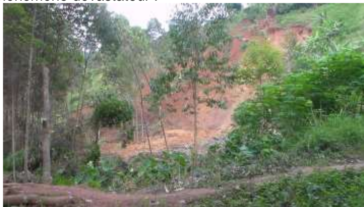
Figure 8 : Gros plan sur un glissement de terrain, de type rotationnel.
