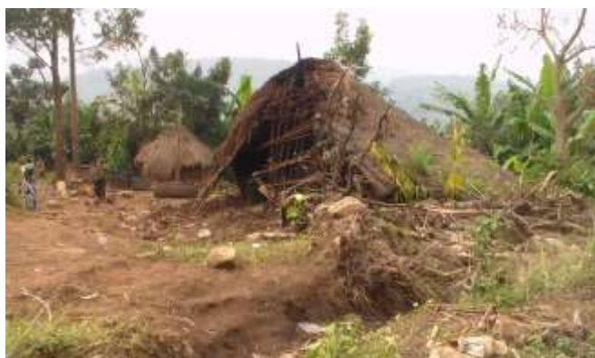
Figure 14 : Habitation détruite par la percussion d'une érythrine charriée par l'écoulement torrentiel.
