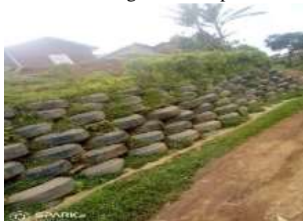
Photo 6. Pneus usagés utilisés pour stabiliser le sol
